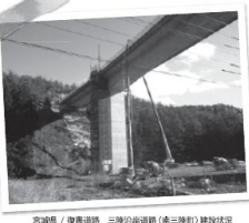
宮城県 / 復興道路 三陸沿岸道路（奥三陸町）建設状況
